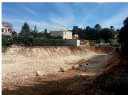
Les travaux de réalisation du bassin d'infiltration de 2800m<sup>3</sup> récupérant les écoulements d'eaux pluviales de la route de Puéchabon au niveau des lotissements du Mas 1 et 2 sont aujourd'hui terminés.
